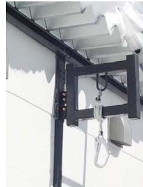
事例4: 雪下ろしのための屋根昇降用ハシゴ固定金物の設置(長野県栄村)
