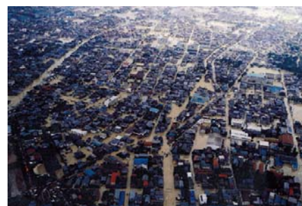
平成16年新潟・福島豪雨で被害を受けた三条市の市街地
