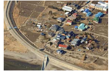
東日本大震災によるおいらせ町川口地区の津波被害（平成23年3月24日）
