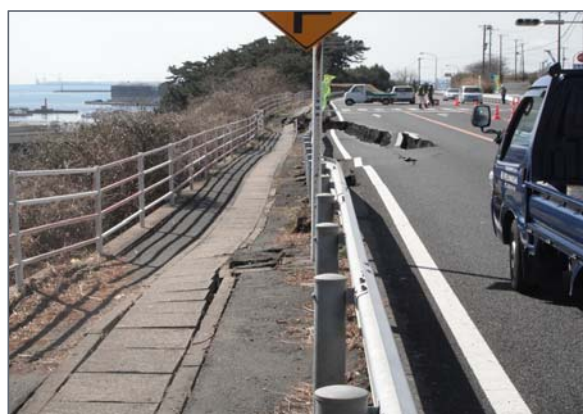
国道245号のがけ崩れ
