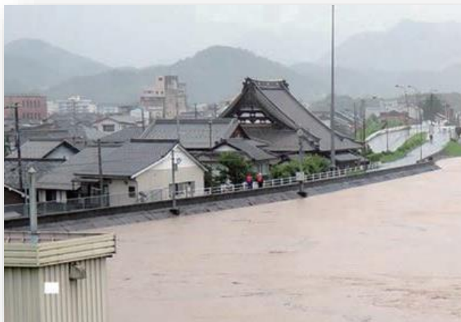
平成25年 台風18号 由良川水位8.30m:計画高水位7.74m
