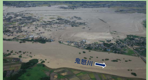
茨城県 常総市 鬼怒川の浸水状況
