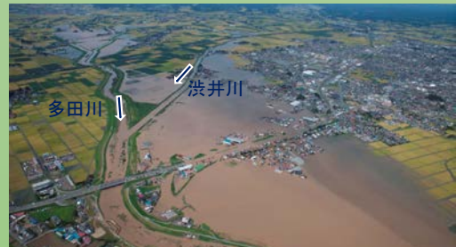
宮城県 大崎市 荒井川の浸水状況
