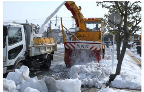
新潟県長岡市から群馬県伊勢崎市への除雪応援 出典：平成26年2月大雪検証報告 （群馬県伊勢崎市）
