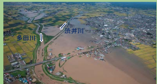
宮城県 大崎市 洪井川の浸水状況
