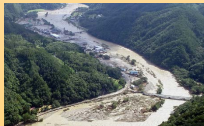
小本川の浸水被害 (岩手県下閉伊郡岩泉町)
