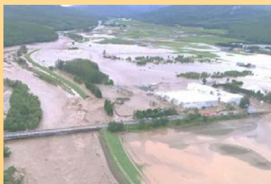
石狩川水系空知川の決壊状況 (北海道空知郡南富良野町)
