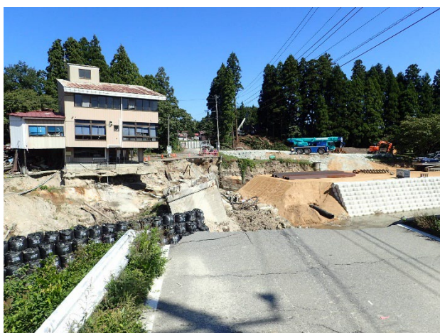
大巻橋崩落現場視察 【小白川下流（飯豊町）】
