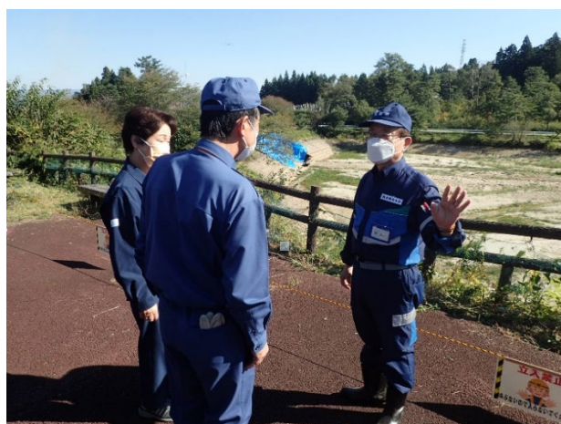
ため池堤体決壊現場視察 【大光院堤1号（川西町）】
