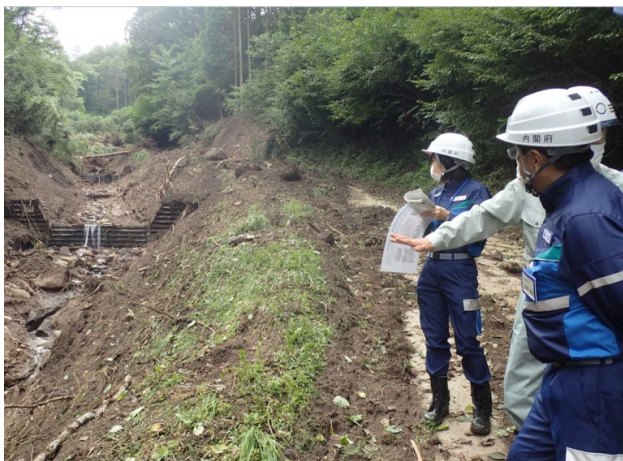
砂防堰堤確認 【岡谷市湊地区】
