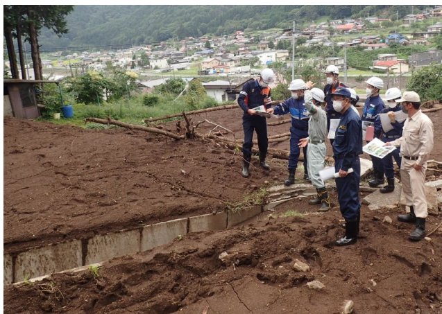
被災現場確認 【岡谷市川岸東地区】
