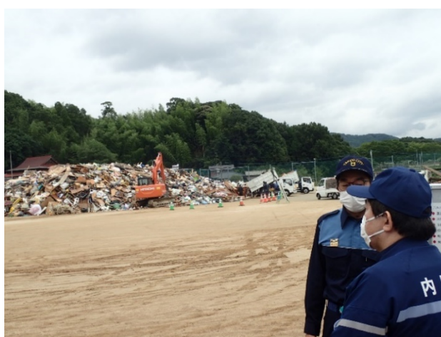
被災現場確認 【武雄市北方運動公園】
