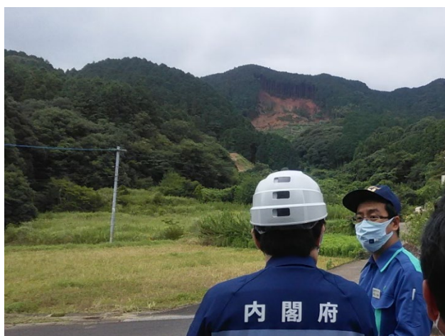
被災現場確認 【嬉野市内野山地区】
