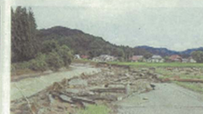
▲町道「関野土橋」(小川地区)
