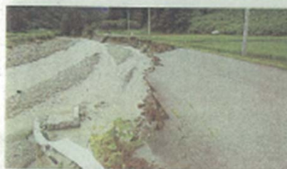
▲町道「小林塩ノ尻」(塩ノ尻地区)
