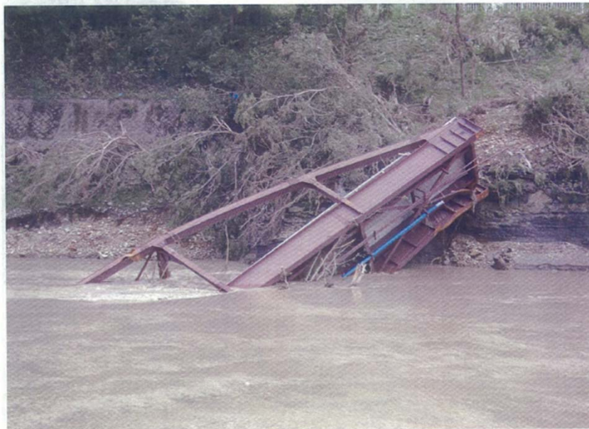
町道西部橋流失 (7月30日)
