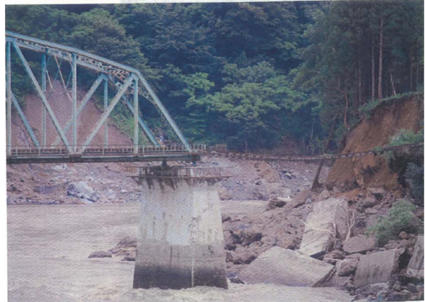
JR只見川第五鉄橋一部流失 (7月30日)
