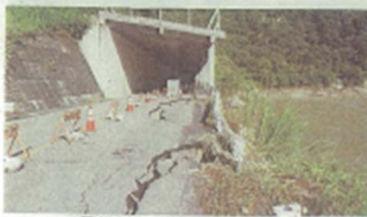
▲国道252号塩沢スノーシェッド付近
