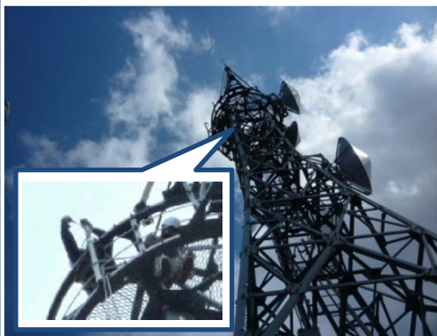
余震が続く中、高所での応急措置
