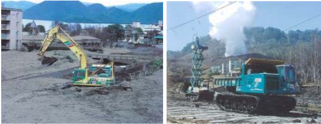
写真 無人化施工の様子(提供：北海道開発局)
