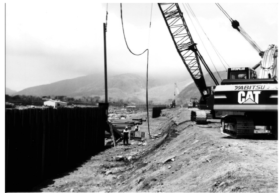
写真2-4 警戒区域内の矢板設置工事の状況 (1994(平成6)年5月12日)(松井宗廣撮影)
