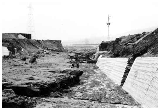
写真2-1 国道57号地点付近の水無川から3号遊砂地を望む（1994（平成6）年6月12日） （松井宗廣撮影）
