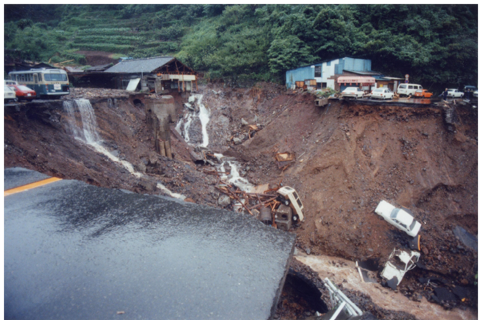
写真4-1 国道34号芒塚の道路流失 提供：DEITz(株)
