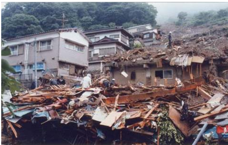
写真 2-1 鳴滝町の土砂崩れ現場 (提供: DEITz(株))
