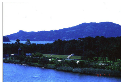
写真8-3 高田海岸第2線堤を陸側から (首藤伸夫撮影)
