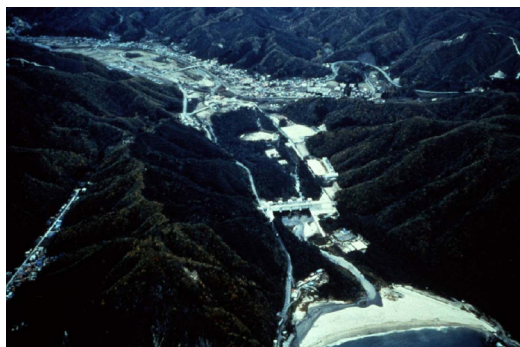
写真8-4 岩手県普代川津波水門
