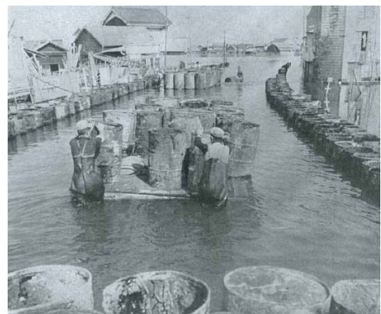
写真コラム10-1 国道1号線蟹江～弥富間の 「ドラム缶工法」現場（中日新聞社、1959）
