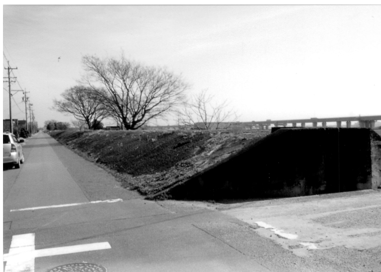
写真 3-3 伊勢湾台風後に築造された鍋田農村団地の囲堤（内堤） 遠景は伊勢湾岸自動車道（2006年10月、伊藤安男撮影）
