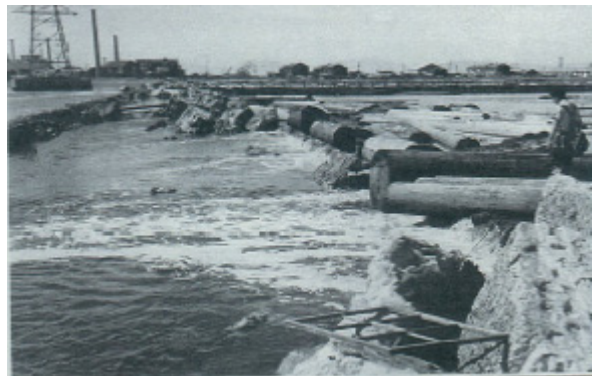
口絵8 完全に破壊された貯木場決壊口
