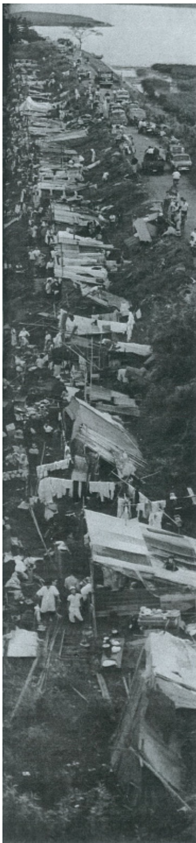
口絵18 庄内川堤防に急設した避難小屋（9月27日） 出典：中日新聞社『伊勢湾台風の全容』
