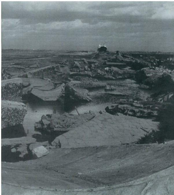
口絵4 寸断された半田市海岸堤防と 打ち上げられた船舶
