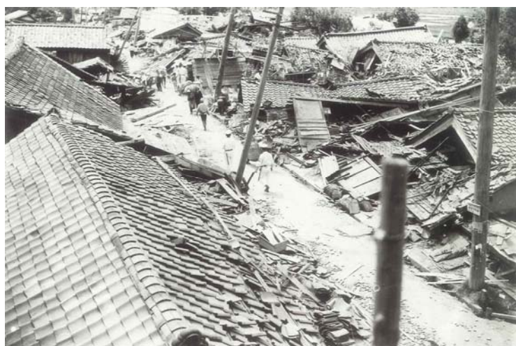
写真4-31 石川県大聖寺町の被害状況
