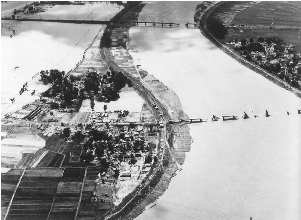
写真4-32 震災から約1ヶ月後の豪雨で浸水した九頭竜川中角橋付近の様子（提供：中日新聞社） 地震で落橋した橋が水没している。地震で被災した地域の復興をあざ笑うかのように、またしても大きな被害が発生した。
