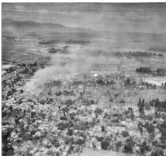
写真4-29 震源地とされている丸岡町の被害状況（谷口, 1998 より一部抜粋）
