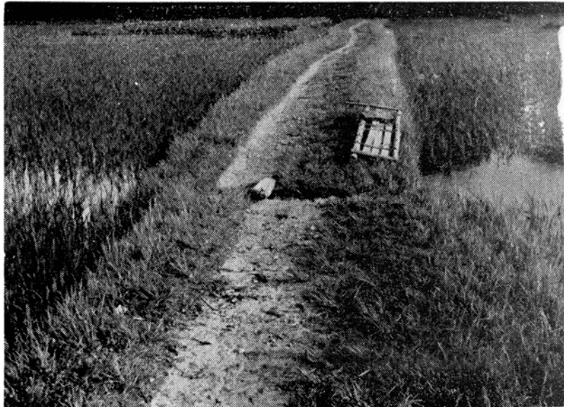
写真2-1 福井地震断層近傍, 坂井市春江町定重に現れた農道の数10cmのずれ 出典：福井市, 1978 道はほぼ南北に伸びており、このずれは東西走向であり、南北走向と推定される福井地震断層による変位とは考えにくい。
