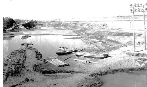
写真 1-14 二次締切と決壊した利根川堤防（11月10日）（国土交通省関東地方整備局利根川上流河川事務所）
