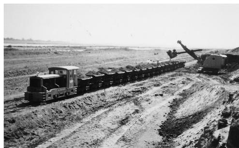
写真 1-38 高水敷及び旧堤掘削状況（国土交通省関東地方整備局利根川上流河川事務所）
