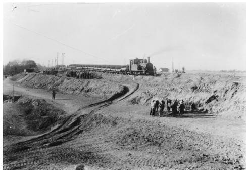
写真1-16 本堤復旧土運搬締め
