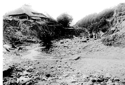
写真1-1 土石流により浸食され谷間と課した状況
