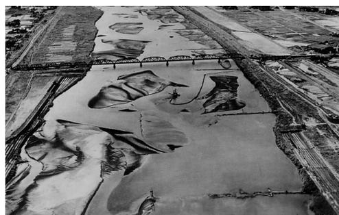
写真 1-37 北川辺町地先の引堤と河床浚渫状況（国土交通省関東地方整備局利根川上流河川事務所）
