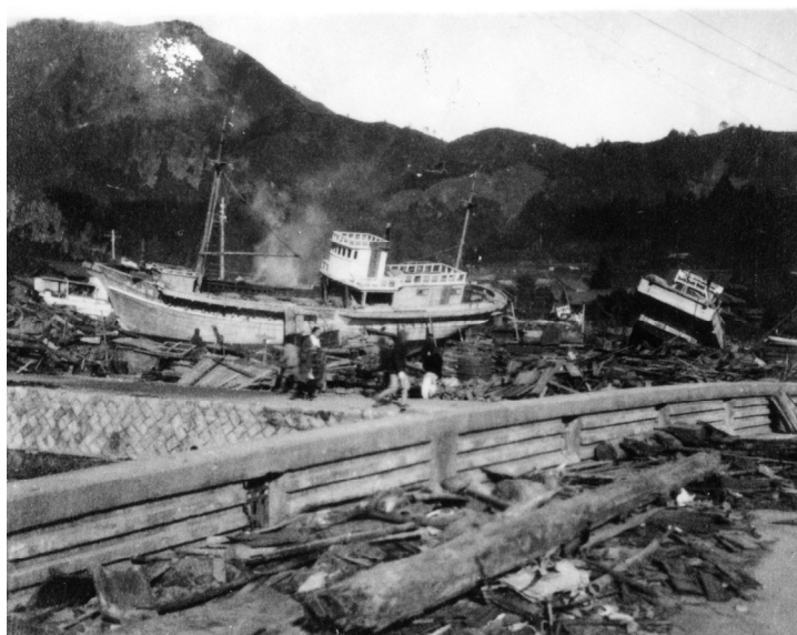
写真6-2 尾鷲の津波被害の様子
