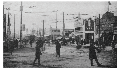
写真1-2 仮設建築物 (神田区小川町交差点付近) (絵葉書,刊記不詳,田中傑所蔵)
