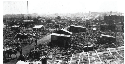
写真1-1 仮設建築物(神田付近) (復興局(1930),帝都復興記念帖,「神田焼跡の焼トタンバラック,神保町より三崎町方面を望む」)
