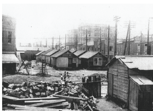
写真1-3 幹線街路予定地に建てられた臨時収容家屋
