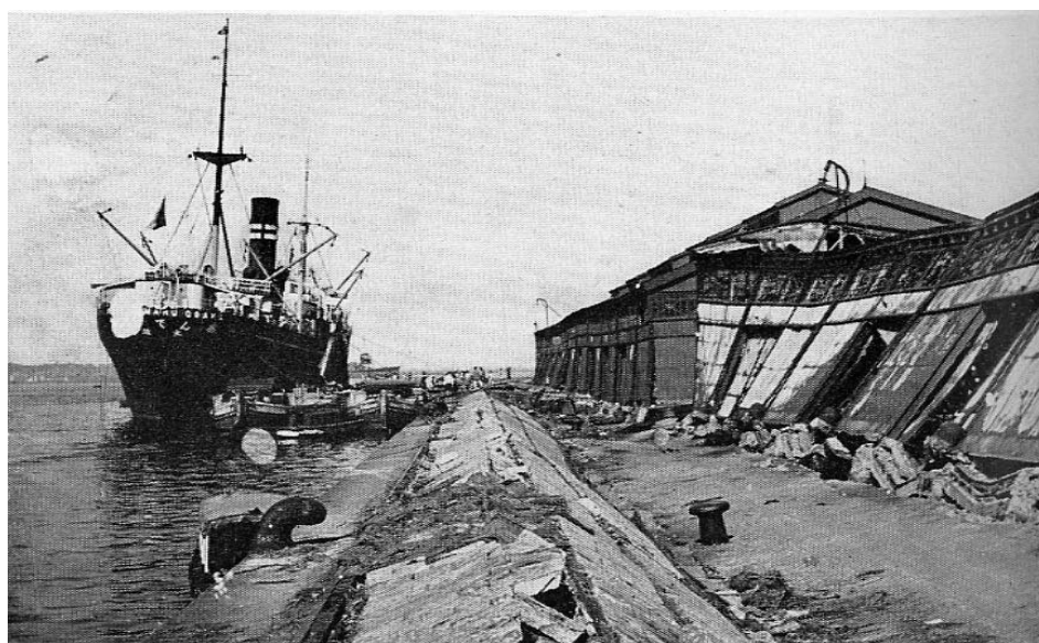
写真3-7 横浜港第六岸壁の被害 [物部長穂, 1926より引用]
