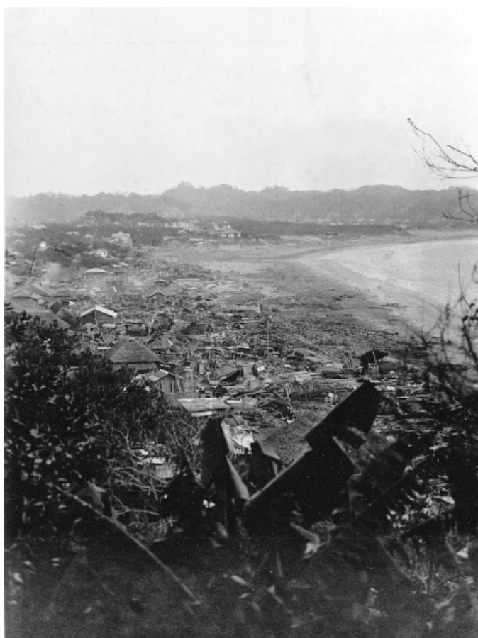
写真3-10 鎌倉における被害。霊山崎から由比ガ浜方面を望む〔鎌倉市中央図書館蔵〕
