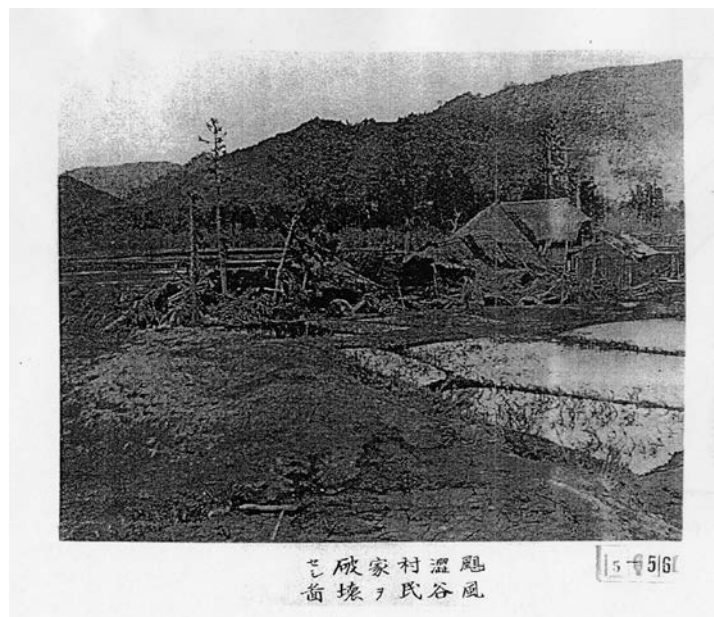
写真1-8 噴火後に破壊された渋谷村の民家と樹木 (宮内庁書陵部所蔵)
