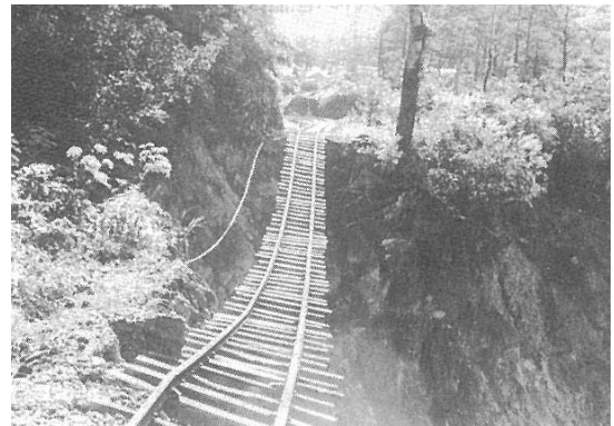
写真4-20 水谷沢付近の軌道欠損箇所
