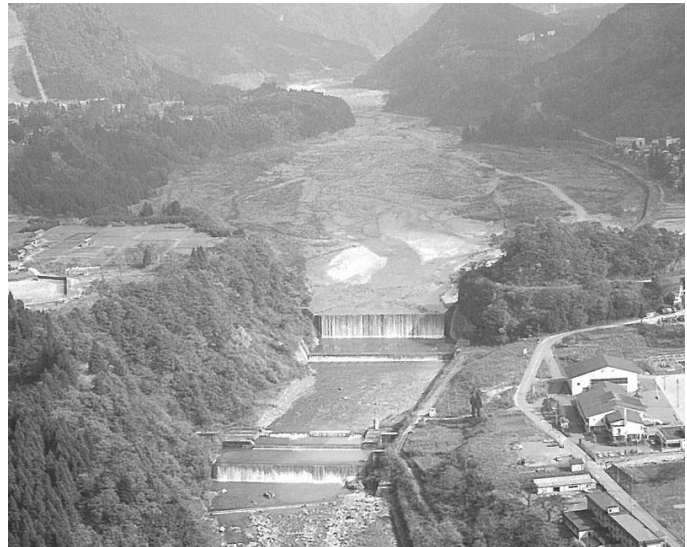
写真4-1 本宮砂防堰堤（立山砂防事務所）
