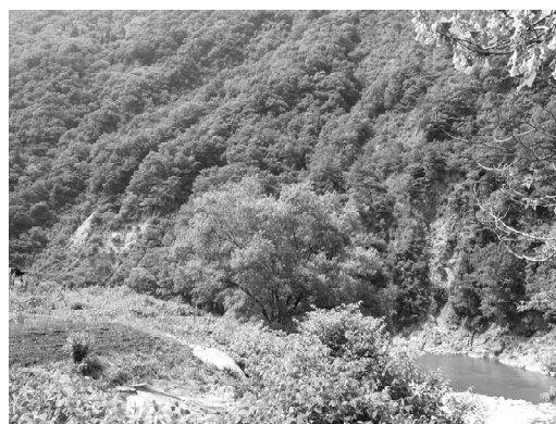
写真2-2 現在の丸山地区崩壊現場 （田添好男撮影）
