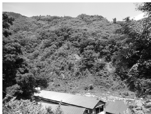
写真2-1 元田荒町地区から見た 現在の崩壊現場（田添好男撮影）
