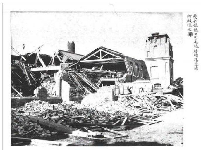
写真 5-2 紡績工場が地震で破壊された様子
