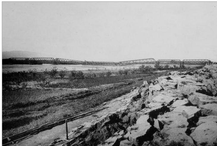
写真 5-3 長良川堤防の崩壊の様子
