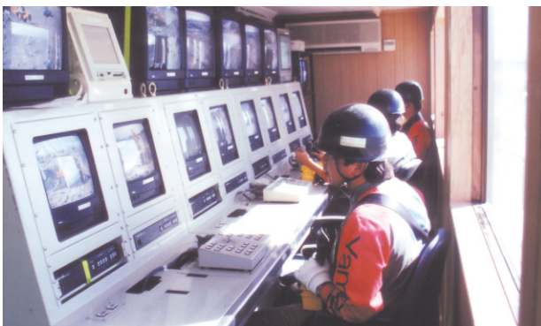
■無人化施工の遠隔操作作業状況(1994(平成6)年4月11日)
