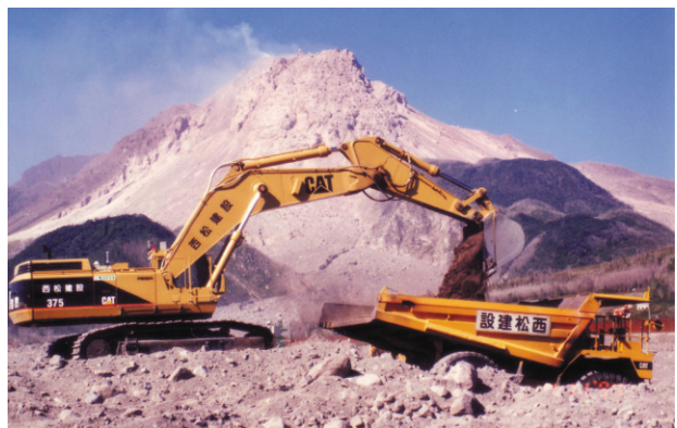
■無人化施工による警戒区域内での除石(1994(平成6)年4月11日) 撮影:松井宗廣
