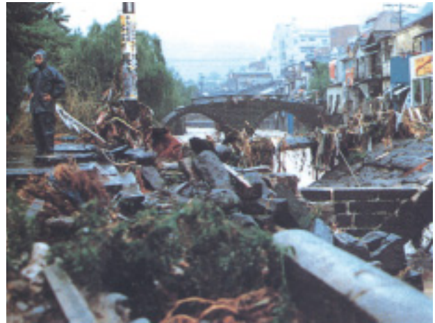
■中島川眼鏡橋付近の被災状況 写真提供：長崎県長崎土木事務所
