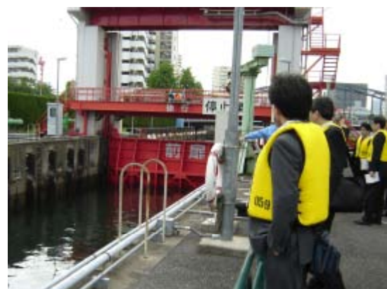
扇橋閘門（内水面が低いため通過する船舶のため、ここで水面の高さを調節する）
