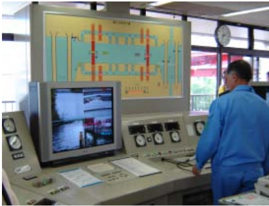
閘門操作の説明の様子
