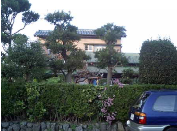
< 平塚：公開耐震補強工事 >
