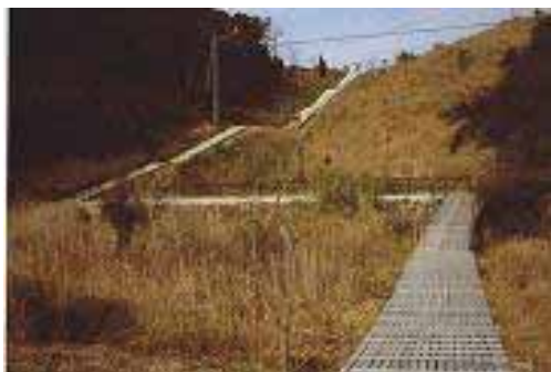
完成した避難路、右下が住民の手作り部分
