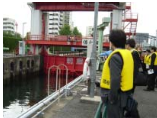
扇橋閘門（内水面が低いため通過する船舶のため、ここで水面の高さを調節する）
