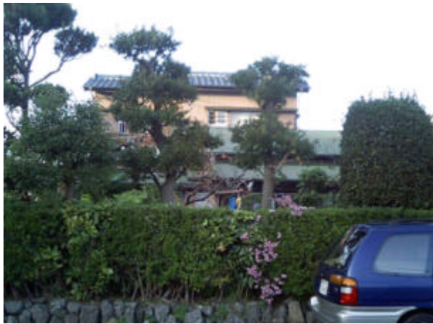
<平塚：公開耐震補強工事>
