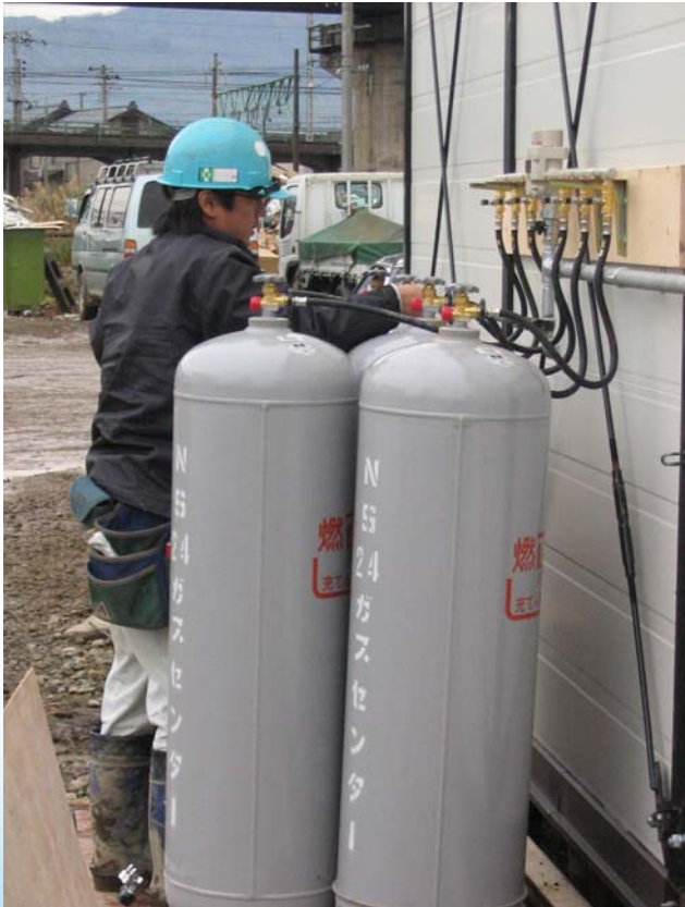
急ピッチで建設が進む長岡市の 仮設住宅(11/18) (写真提供: ㈱石油化学新聞社)
