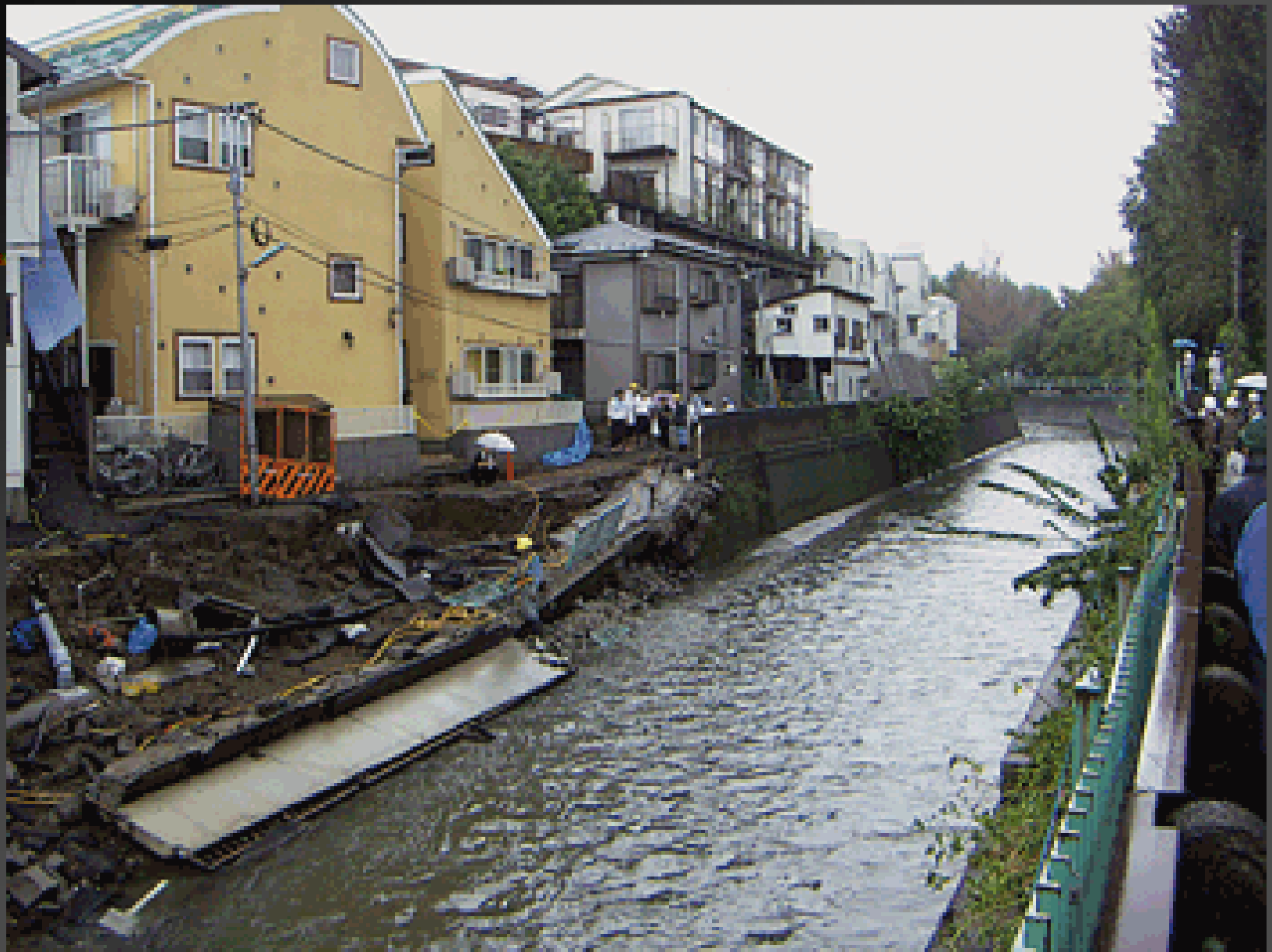
平成17年9月5日妙正寺川の被災状況(中野区)
