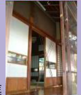
耐震補強工事の一例
