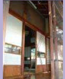
耐震補強工事の一例
