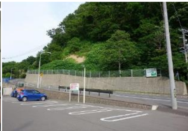
津波避難所に向かう坂道
