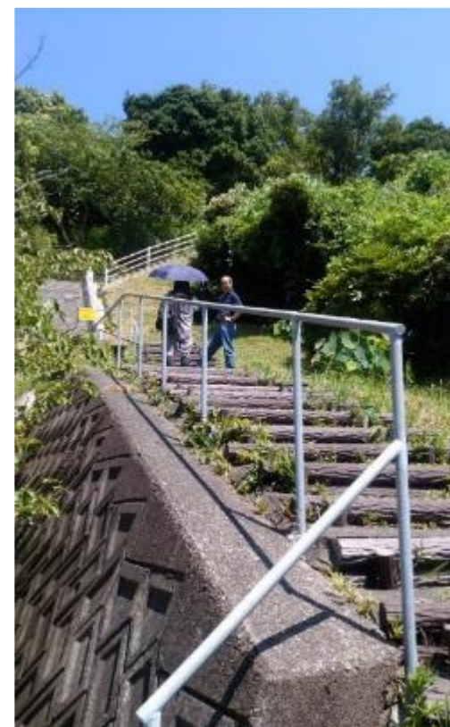
地区が設置した高台避難路
