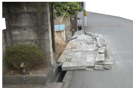
東日本大震災 倒れたブロック塀
