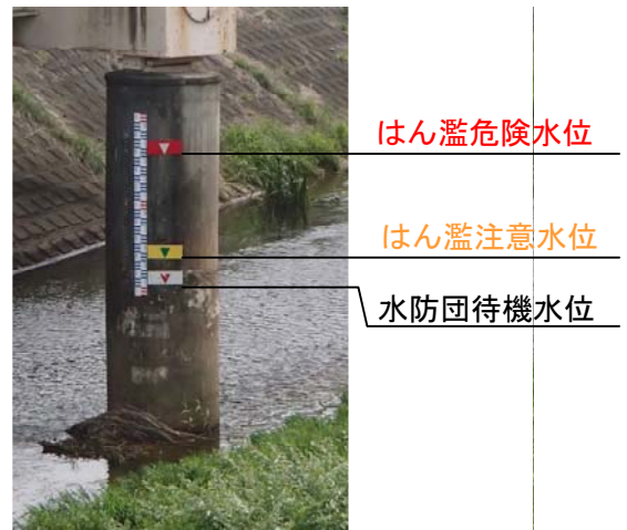
大手町5丁目付近 大手橋 橋脚水位表示板
