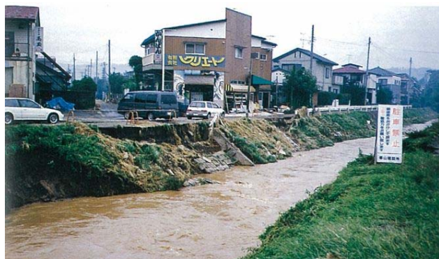
平成 6 年 9 月 22 日 集中豪雨災害時 増田川増水による法面崩落 (増田西地区大手町付近)
