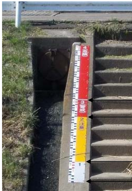
上増田観測所の量水計（増田飯野坂橋付近）
