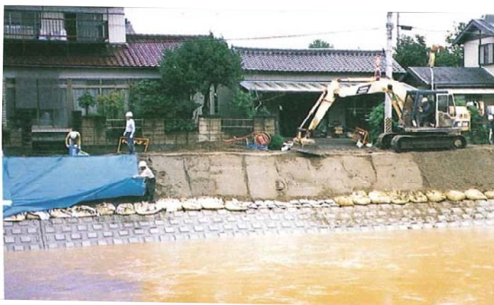
9・22 集中豪雨 増田川の応急工事
