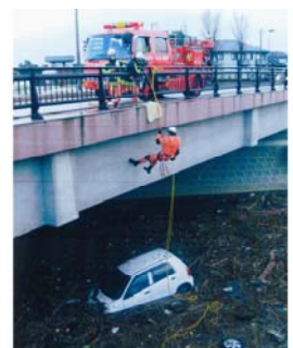
東日本大震災時の増田西大橋
