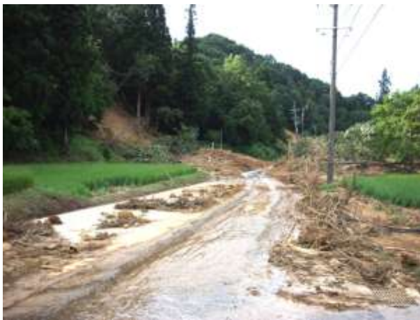
(旧下田村の被害)
