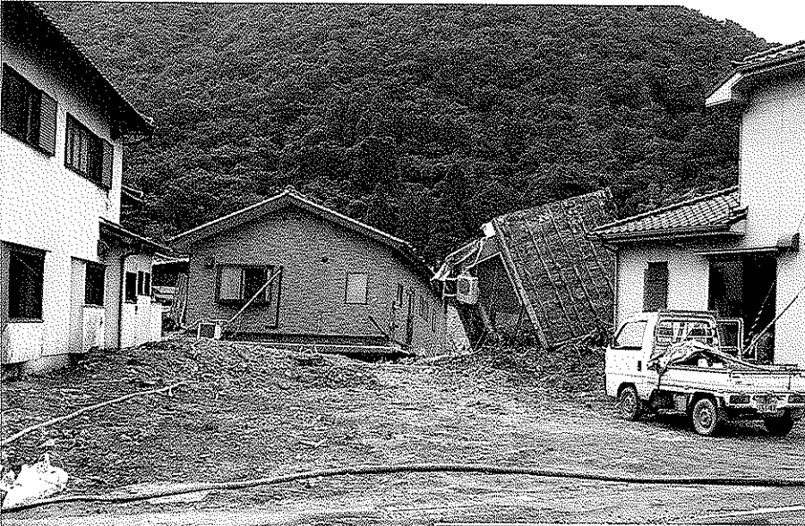
洪水、家屋倒壊など甚大な被害 (佐用町内)
