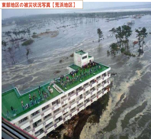
東部地区の被災状況写真【荒浜地区】
