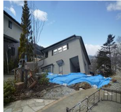
宅地の被害状況写真(2)
