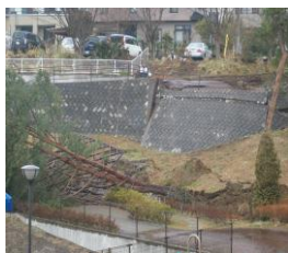
宅地の被害状況写真(1)
