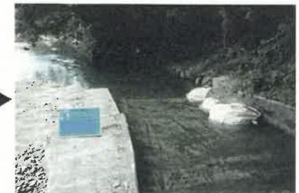
土砂が堆積した頭首工の査定前着工による応急復旧
