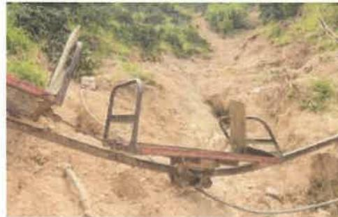
土砂で破壊された運搬設備
